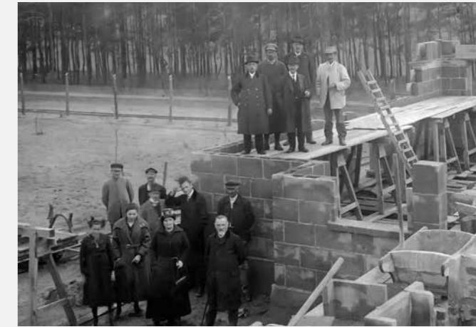
Joseph Weißenberg besucht die Bauarbeiten.
